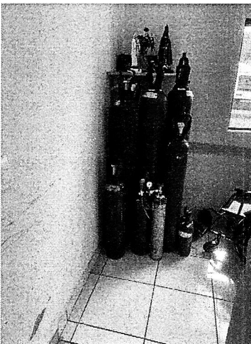
30.9. Cilindro Nao Fixado Recepção
