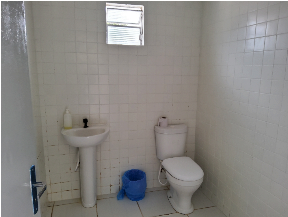
Banheiro de funcionários
