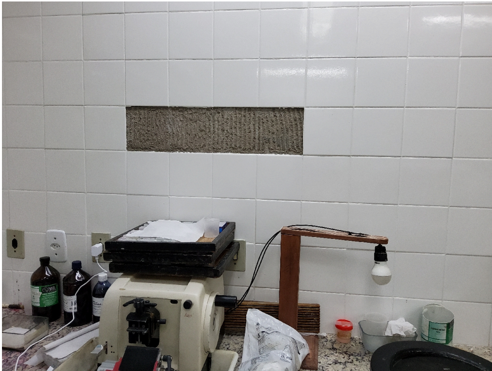
Instalações livres de trincas, rachaduras, mofos e/ou infiltrações
