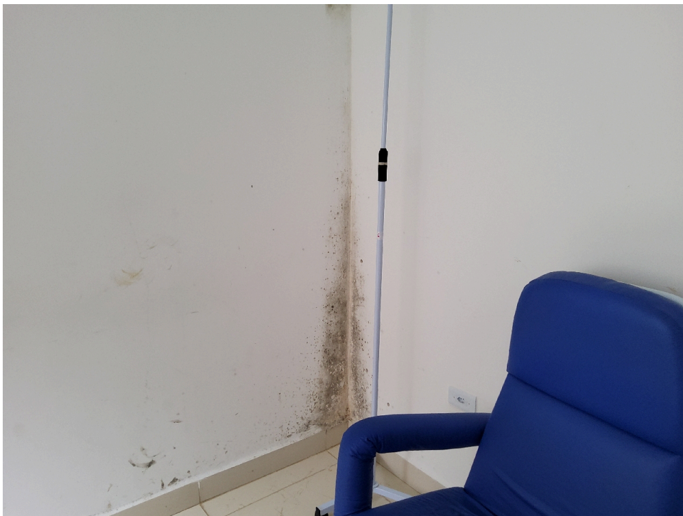
Sala de observação (observar infiltração)
