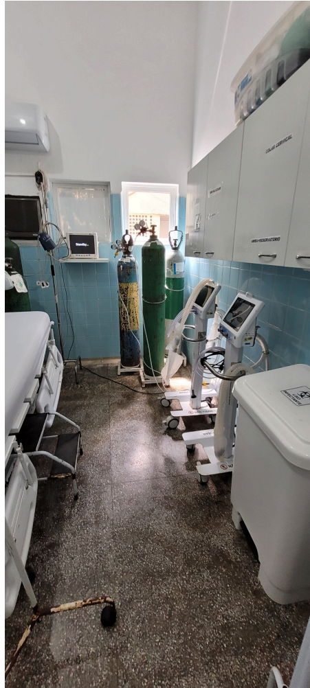
sala vermelha com cilindros de oxigênio sem fixação
