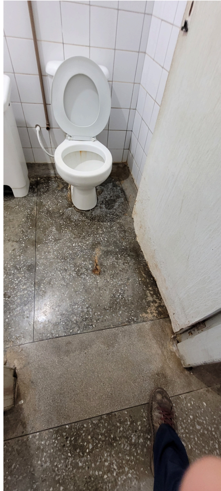
banheiro feminino da sala de espera
