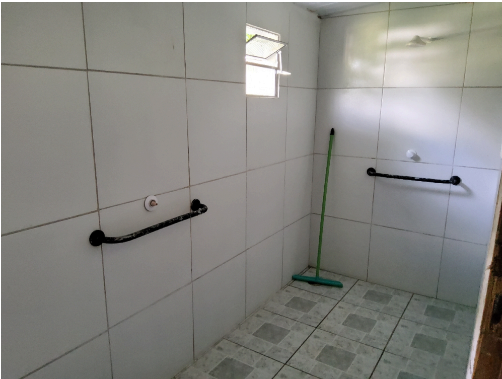
Banheiro enfermaria (foto 1)
