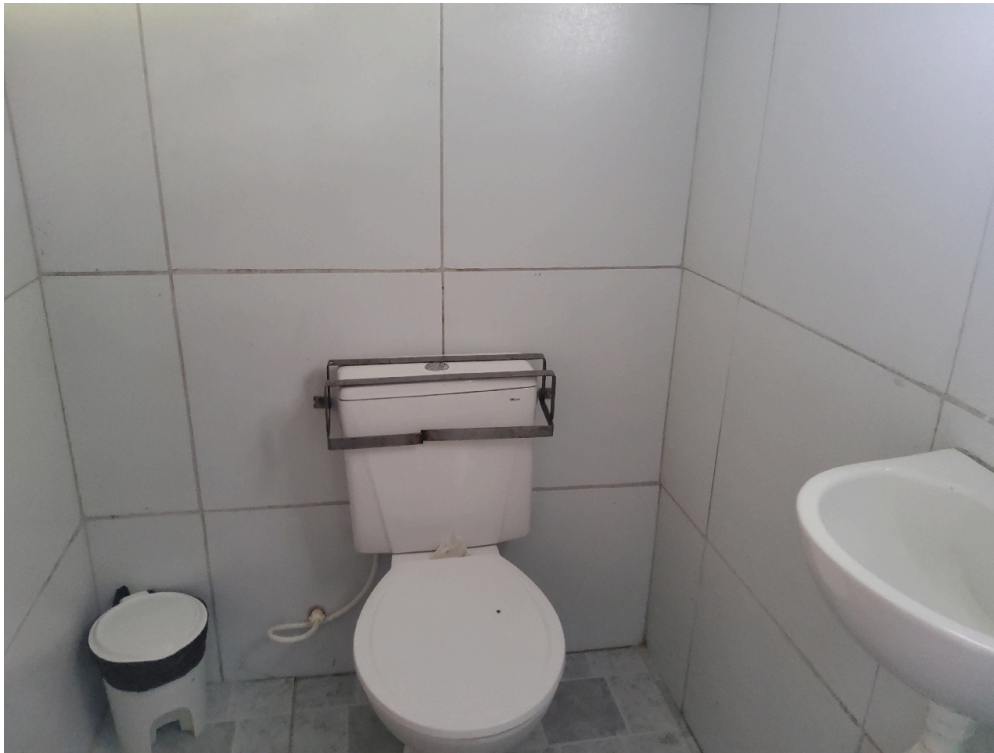
Banheiro enfermaria (foto 2)
