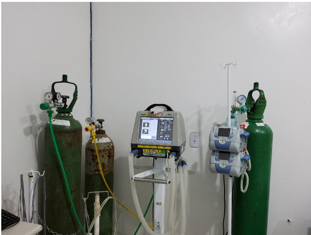
Ventilador e bombas de infusão da sala vermelha
