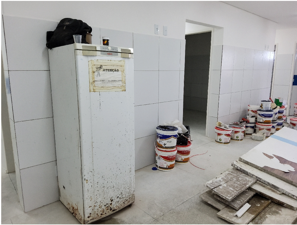
Geladeira dos funcionários no meio da reforma
