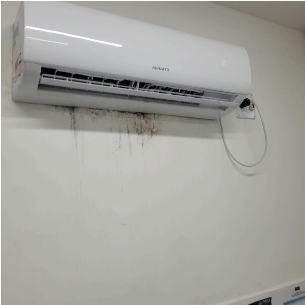
infiltração identificada em um dos aparelhos de ar condicionado
