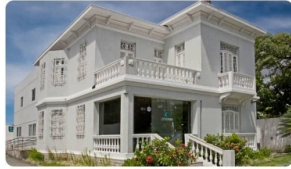
Oftalmax – Hospital de Olhos - Recife / Madalena Rua Benfica, 411
